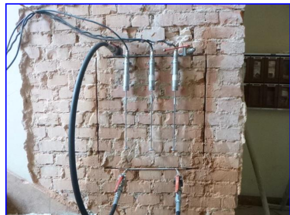
Foto 31: Sensori e martinetti installati per la prova a compressione
