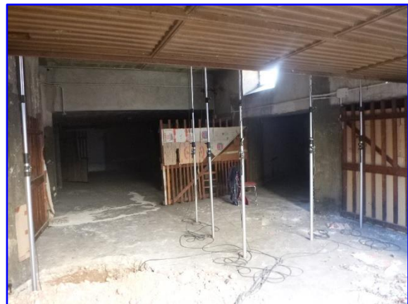
Foto 36: Sensori montati su aste per rilevare i cedimenti in tempo reale
