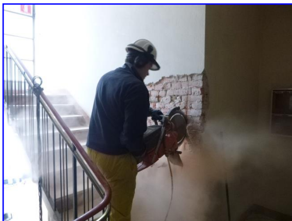
Foto 30: Esecuzione del taglio verticale per la realizzazione della prova
