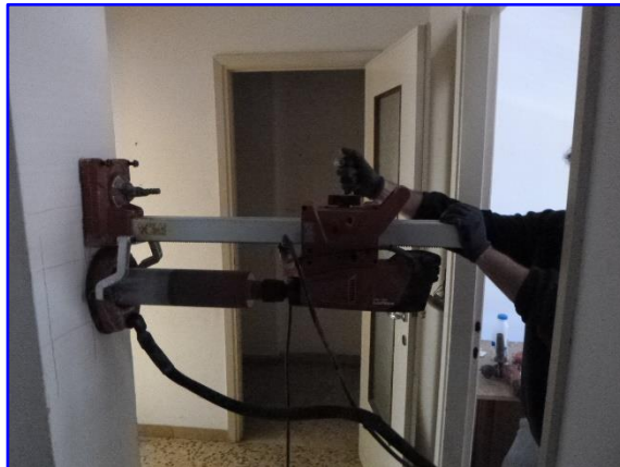
Foto 5: Carotaggio su pilastro
