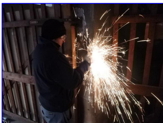
Foto 1: Smerigliatura armatura
