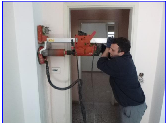
Foto 6: Carotaggio su pilastro
