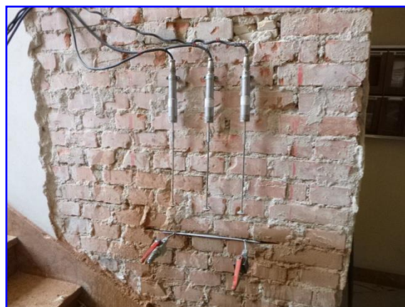
Foto 29: Sensori e martinetto installati per il carico d’esercizio
