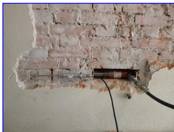
Foto 27: Sensore e martinetto installati
