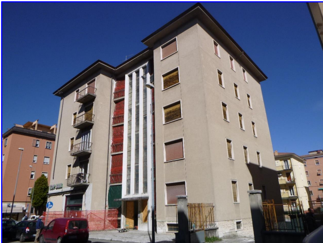
Panoramica dell'edificio ATER oggetto d'indagini
