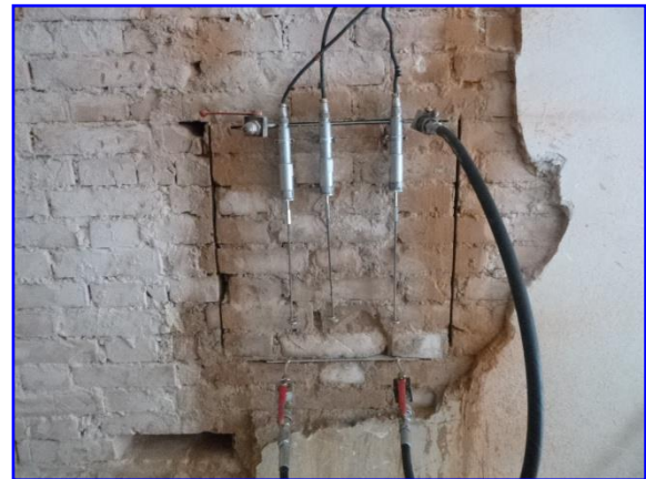
Foto 25: Sensori e martinetti installati per la prova a compressione
