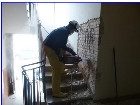
Foto 28: Esecuzione del taglio orizzontale per l’inserimento del martinetto
