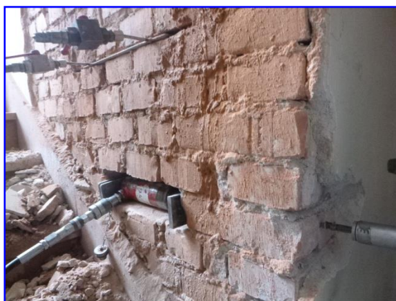
Foto 32: Panoramica della prova a taglio
