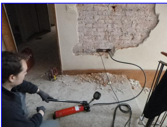
Foto 26: Panoramica della prova a taglio
